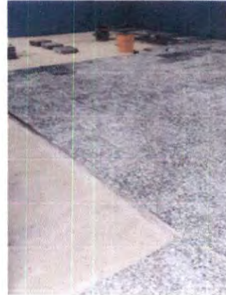
Foto 2: Mejoramiento de piso de aula multigrado de primero a sexto y bodega
