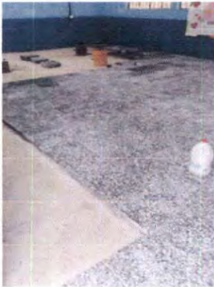
Foto1: Mejoramiento de piso de aula multigrado de primero a sexto y bodega
