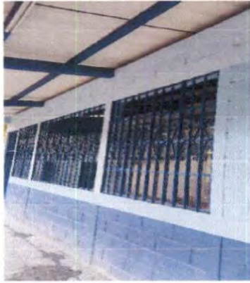
Foto1: Mejoramiento de balcones de aula multigrado de primero a sexto y bodega
