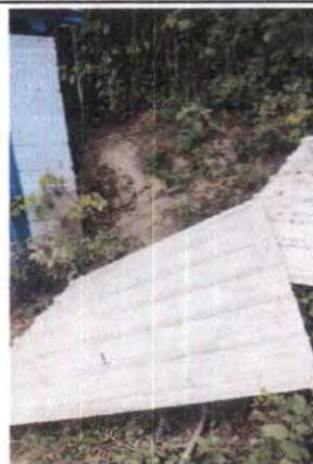
Foto 2: Mejoramiento de baño (techo y taza) de la escuela multigrado
