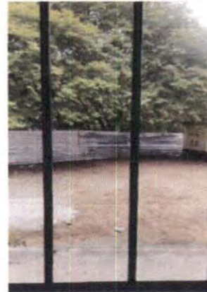
Foto 2: Mejoramiento de balcones de aula multigrado de primero a sexto y bodega
